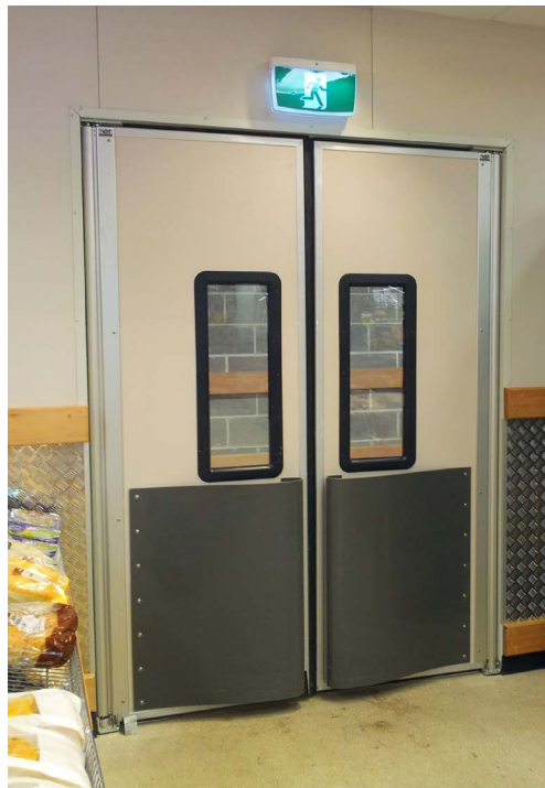
Puerta de Alto Tráfico Posee bisagras de vaivén para permitir un mayor tráfico de personas y carros.
