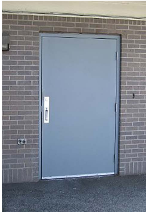
Puerta Resistente al Fuego Permite contener el paso de las llamas, gases y calor por un período de hasta 120 minutos.
